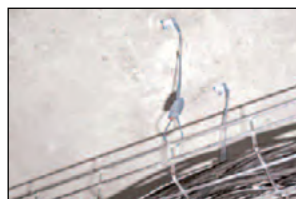
Легкие кабельные лотки / светильники
