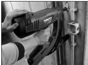
Крепление жесткого кабелепровода
