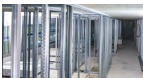
Крепление профилей для ГКЛ к бетону и стали
