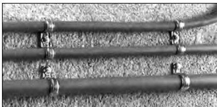
X-FB для жестких кабель-каналов
