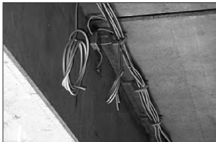
X-ECH для крепления многожильных кабелей
