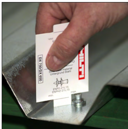
Проверка высоты смонтированного кровельного гвоздя X-ENP 19 при помощи пластикового шаблона
