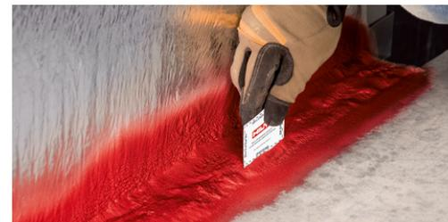
Противопожарный спрей Hilti: обеспечивает быструю и эффективную герметизацию широких стыков, где требуется максимальная подвижность, например, между несущими стенами или в швах между стеной и потолком.
