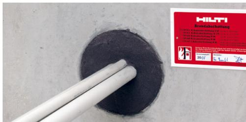
Противопожарный акриловый герметик Hilti: эффективно блокирует пламя и дым, проникающие через зазоры в системах вентиляции, теплоснабжения, горячего и холодного водоснабжения и пожаротушения.
