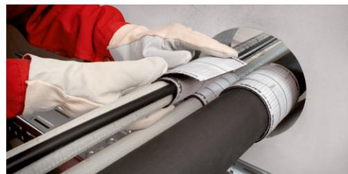
Противопожарная муфта ленточного типа Hilti: универсальное решение, предназначенное для противопожарной защиты стальных и пластиковых труб.
