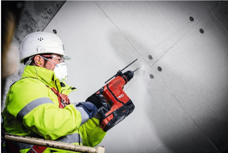
*Крепление сборных противопожарных панелей*
