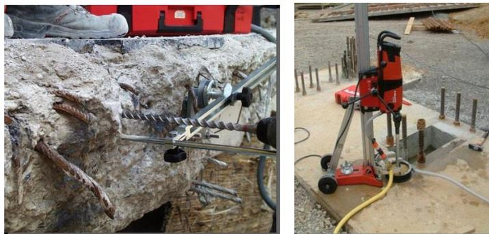
**Рисунок 2.9:** Вспомогательные устройства для бурения
